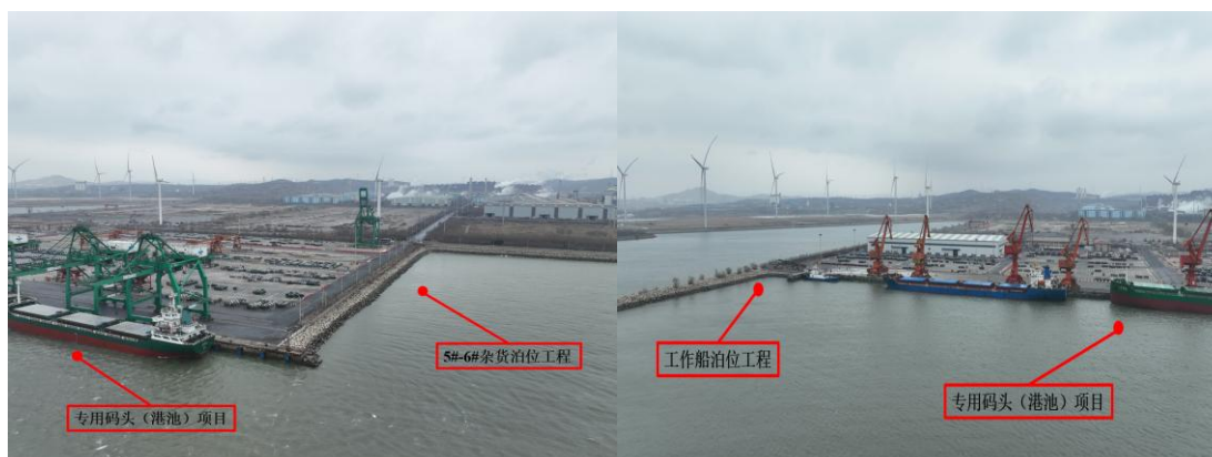
图4.1-3 现场勘查照片
